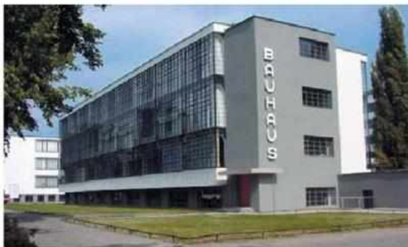
Edificio de La Bauhaus, Gropius.
