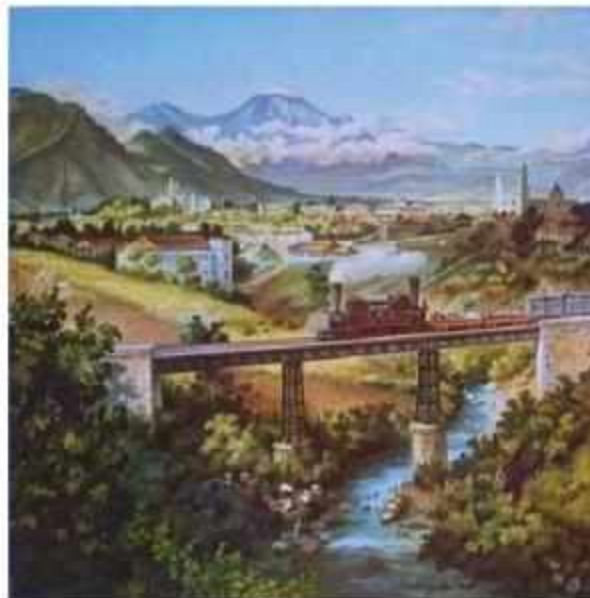
Orizaba desde el Puente del Paso del Toro (detalle), Álbum del Ferrocarril Mexicano, Casimiro Castro, 1877.
