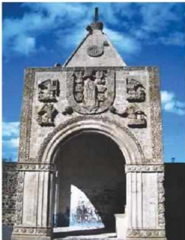
Capilla posa en el Convento de San Francisco Calpan, Puebla.
