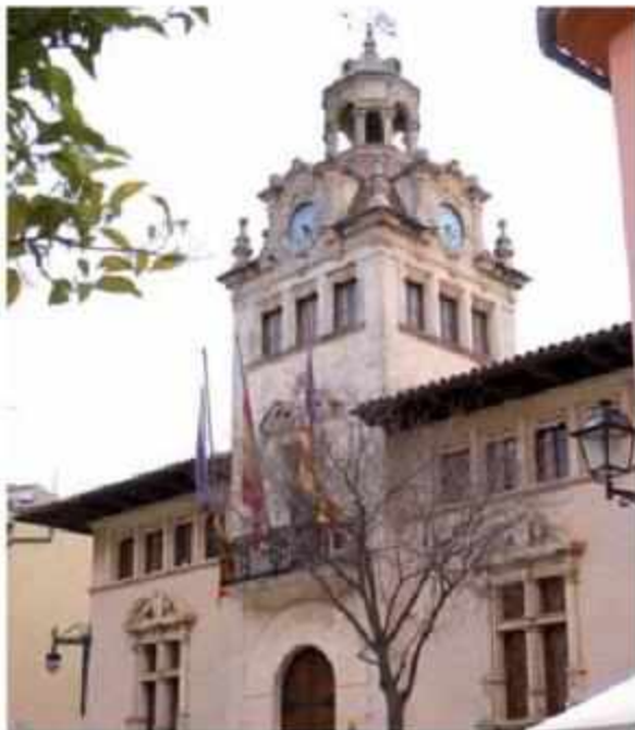
Edificio del Ayuntamiento de Alcúdia, en Mallorca, España, Carlos Garau Tomabells, 1929. Obra representativa de la arquitectura racionalista balear.
